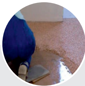
Układanie powierzchni TopStone
