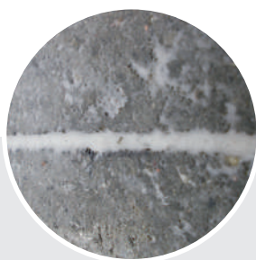
Penetracja i uszczelnienie
